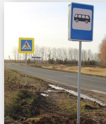
Композитная стойка На металлической стойке видна коррозия и отслоение краски
