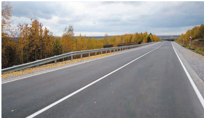
Отремонтированный участок автодороги Горбуновское – Байкалово – Ирбит
