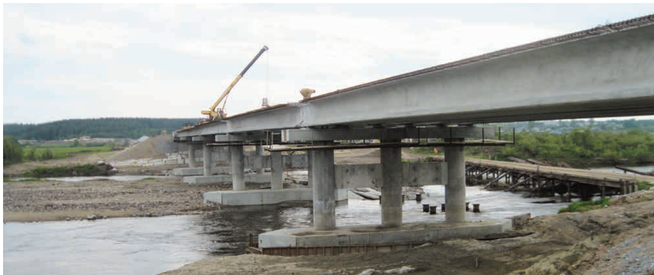
Мост через р. Ница в Свердловской области. Работы производит филиал ЗАО «Уралмостстрой» – «Мостоотряд №82»
