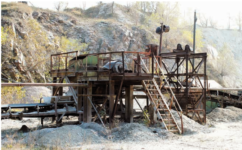
Многие российские предприятия по выпуску щебня работают на морально и физически устаревшем оборудовании
